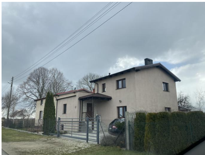
Budynki mieszkalne jednorodzinne
