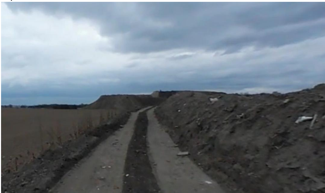
Ryc. 14 Widok na budowlę ziemną zlokalizowaną w sąsiedztwie lotniska Żerniki oraz rzeki Kopel
