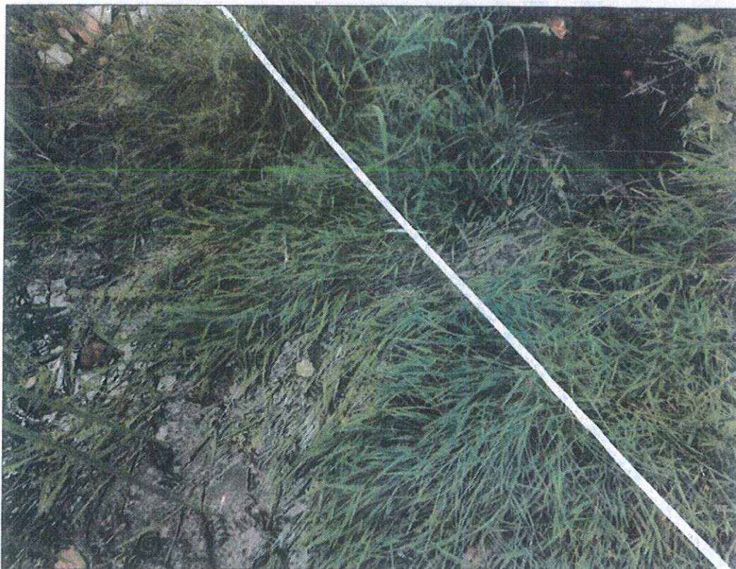
Foto. 24. Fragmentu lokalnej drogi gruntowej pomiędzy zbiornikami na działce nr 190/8; miejsce przyszłej grobli z przepustami i zbudowaną na jej szczycie nawierzchnią drogi docelowej. Widoczne samoistne przepływy wody pomiędzy zbiornikami o zróżnicowanych poziomach.
