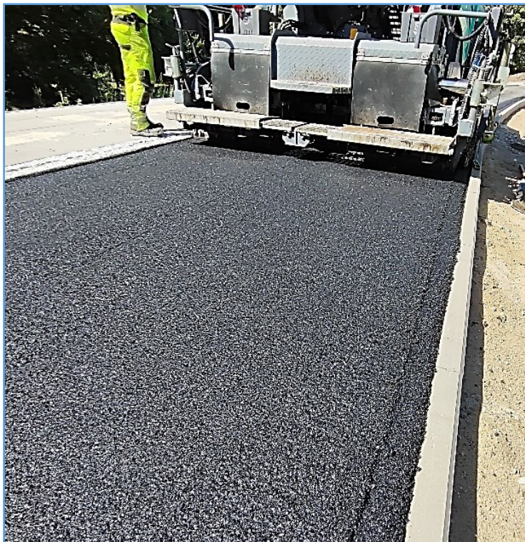
droga rowerowa w technologii masy bitumicznej
