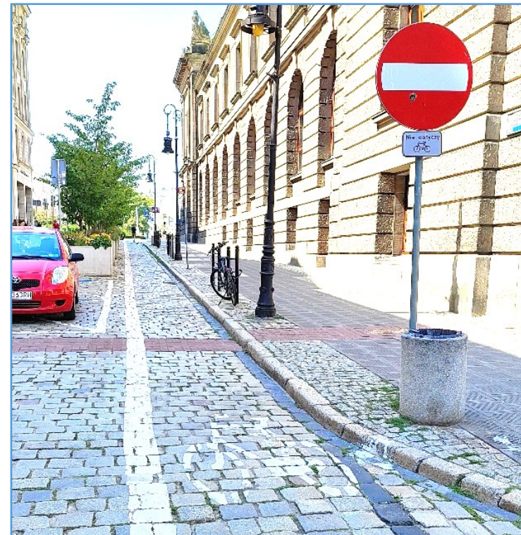
droga dla rowerów z kostki kamiennej
