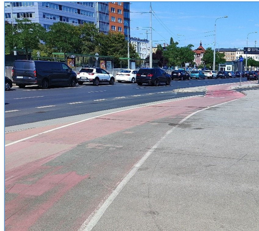
droga rowerowa w technologii betonu monolitycznego
