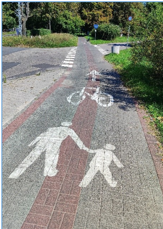
droga dla pieszych i rowerów z kostki betonowej
