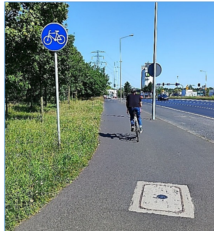
obiekty na nawierzchni – studnia teletechniczna
