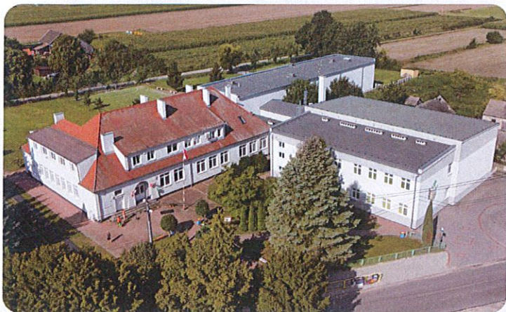
Rozbudowa i termomodernizacja Szkola Podstawowa w Radzewie
