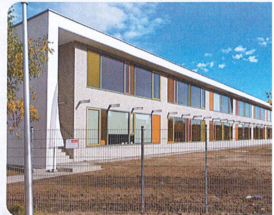
Rozbudowa Szkola Podstawowa w Kami
