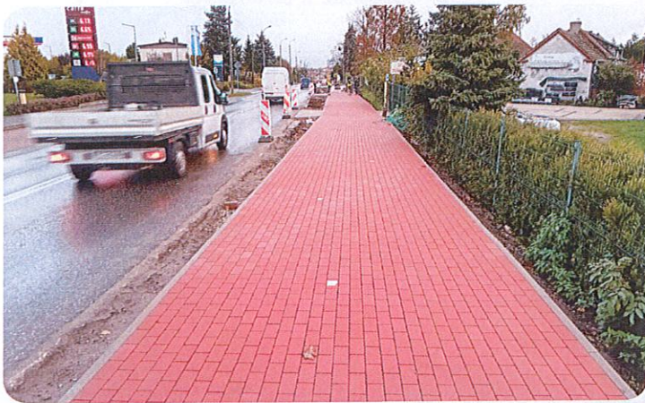
Ścieżka pieszo-rowerowa wzdłuż ul. Śremskiej, Kórnik-Bnin
