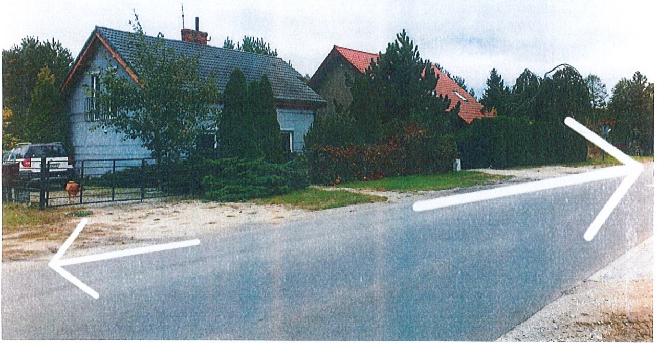
Zalokowane pobocze ul. Pilsarska w Koninku
