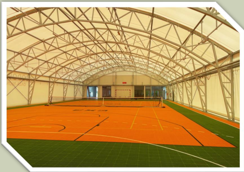
Budowa boiska-lodowiska w Kórniku
