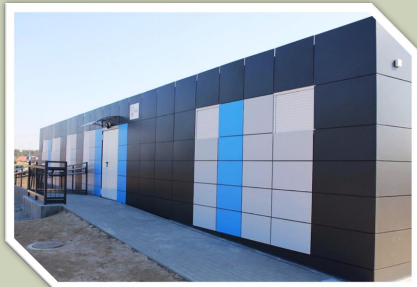
Budowa zaplecza szatniowego w Kamionkach
