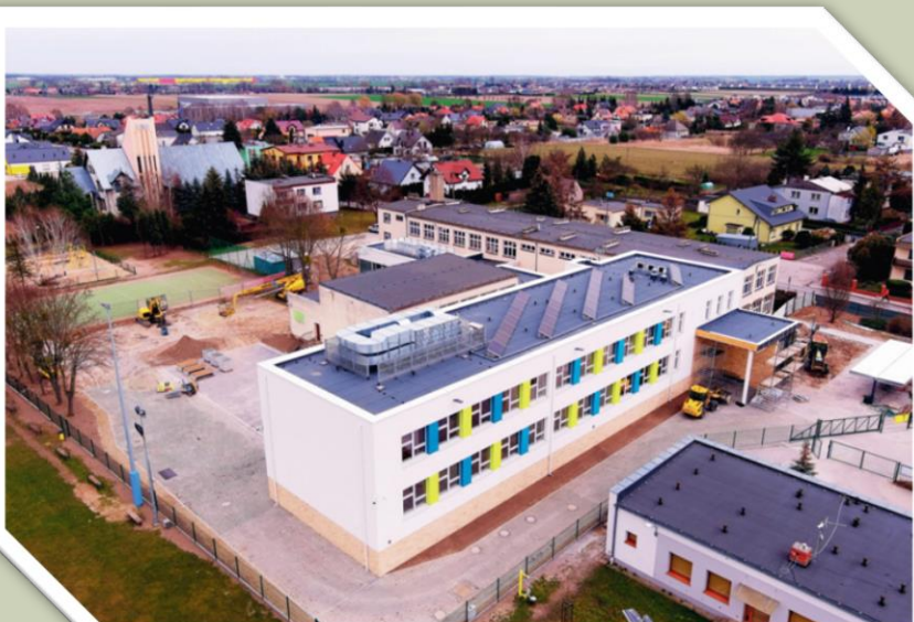
Rozbudowa i termomodernizacja Szkoły Podstawowej w Robakowie
